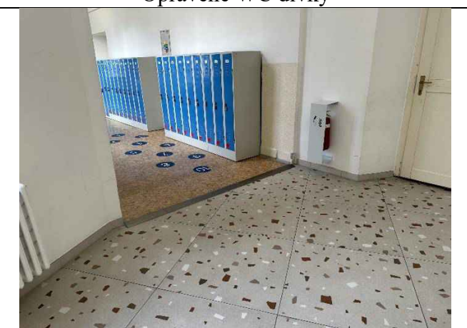
Přechod mezi opravenou a původní podlahou
