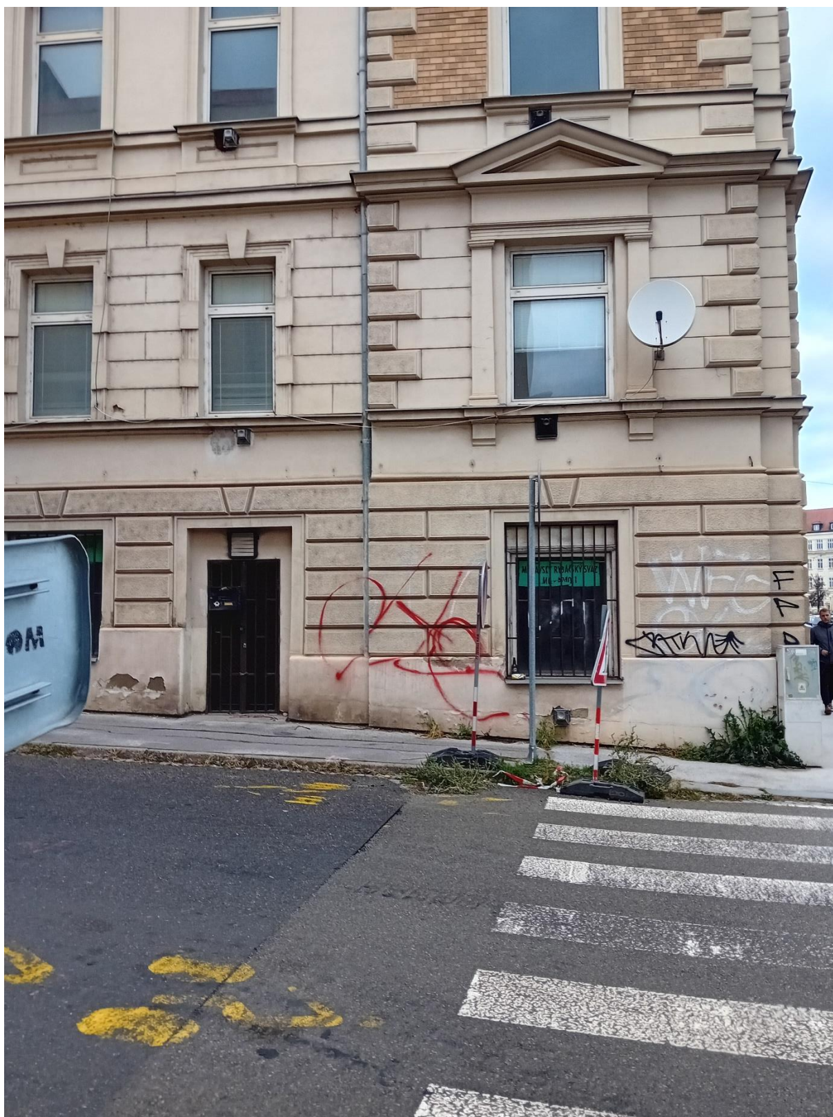
Vstup do nebytového prostoru v přízemí z ulice Kamenná a pohled na satelitní anténu umístěnou na fasádě domu
