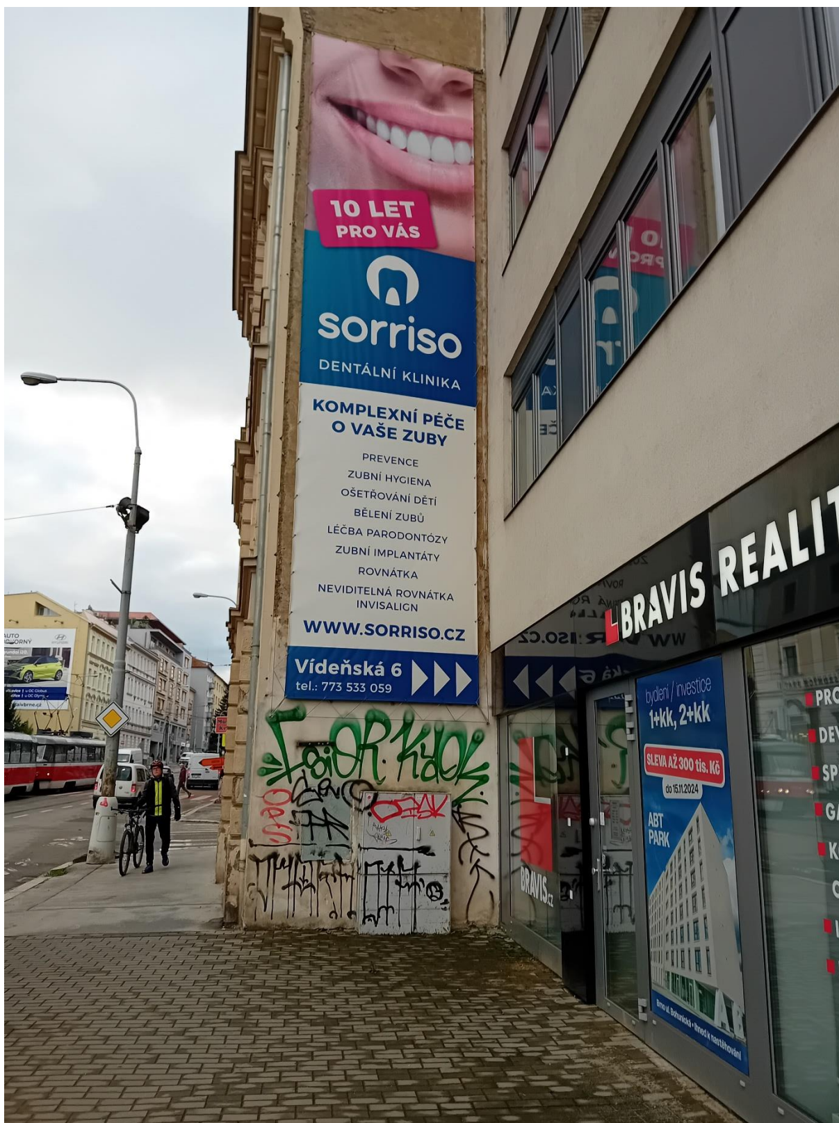
Pohled na reklamu firmy Sorriso Dental na štítové zdi domu v ulici Václavská, rozvodnou skříň ve vlastnictví EG.D umístěnou těsně u zdi domu a plechová dvířka ve zdi bez označení.
