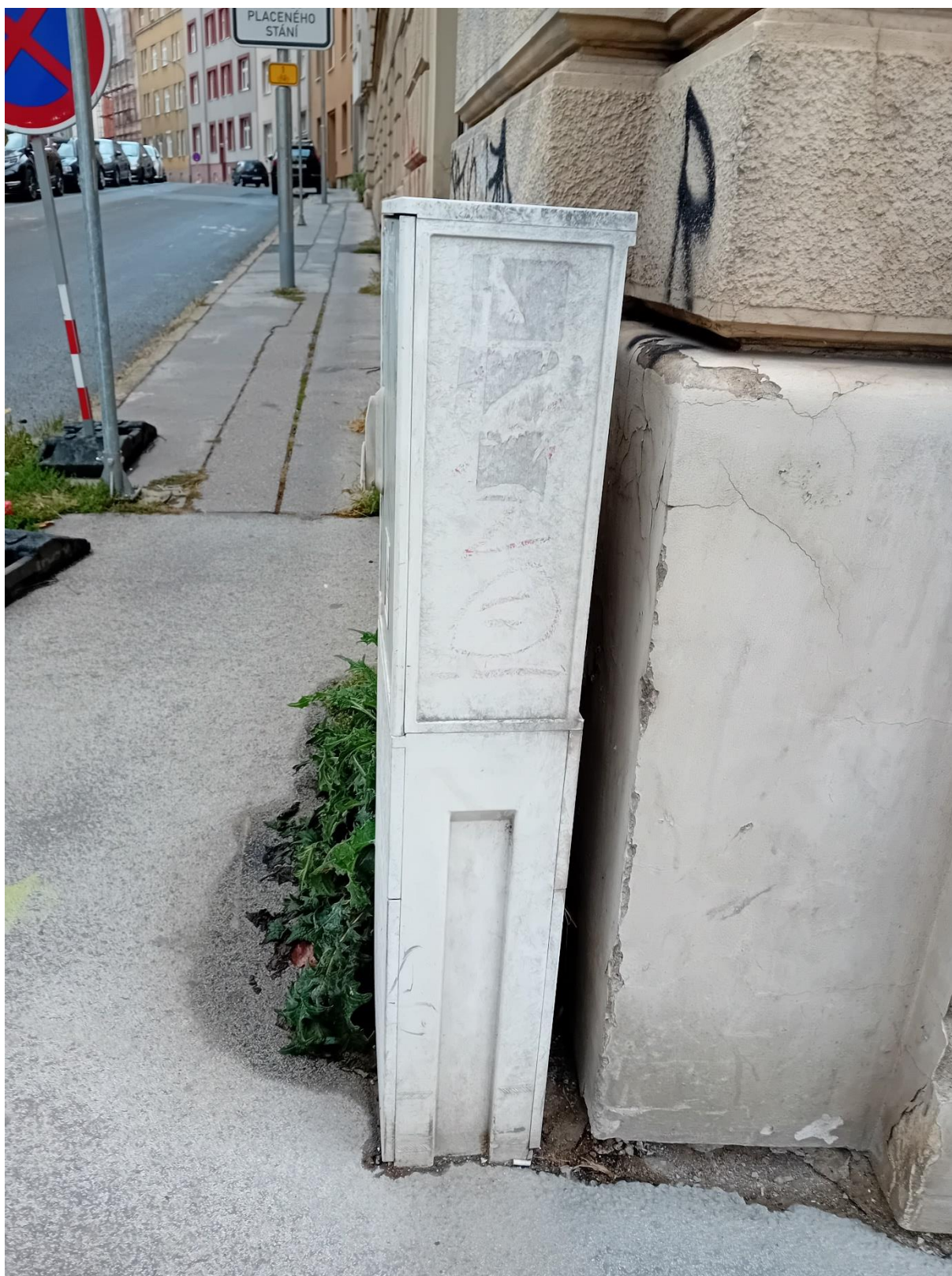
Pohled na mezeru mezi rozpínací skříňí a zdí domu Kamenná 2
