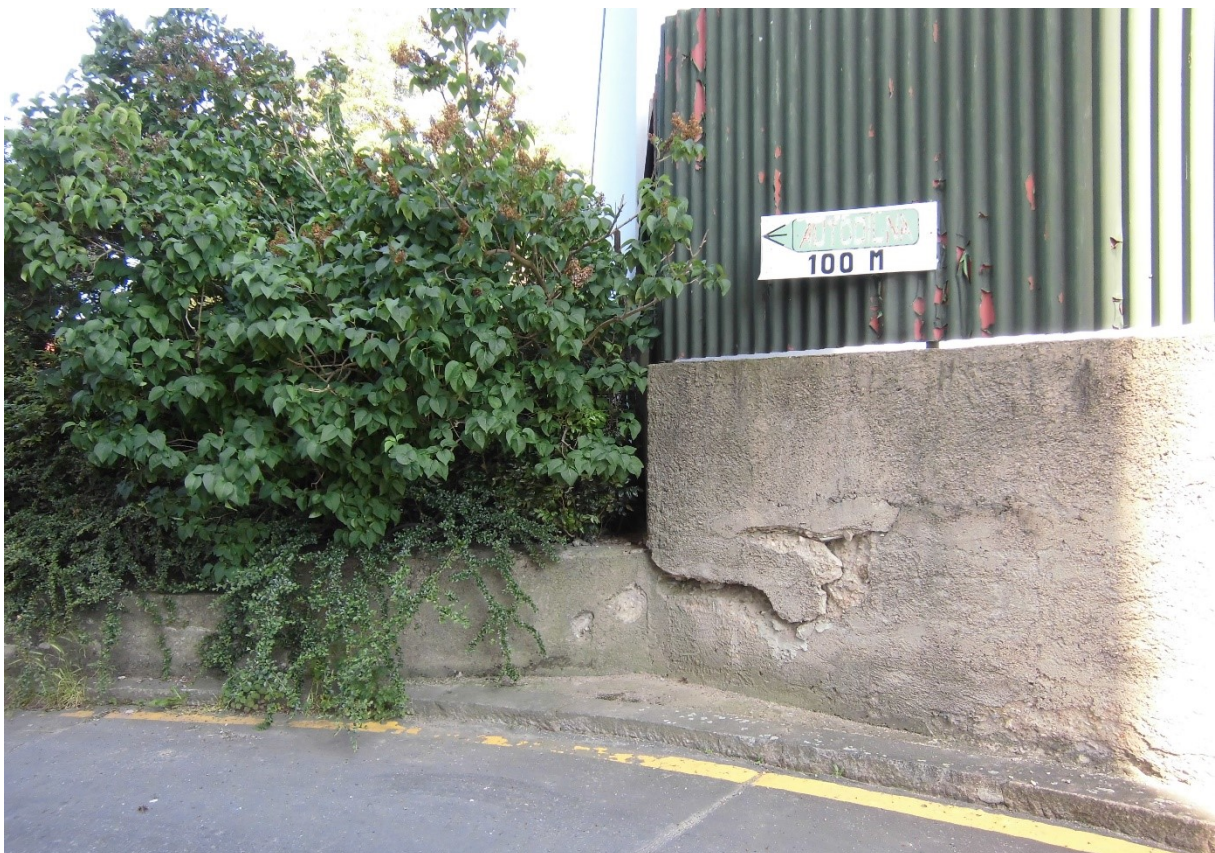
část pozemku p.č. 1744/20, k.ú. Žabovřesky s betonovou podezdívkou
