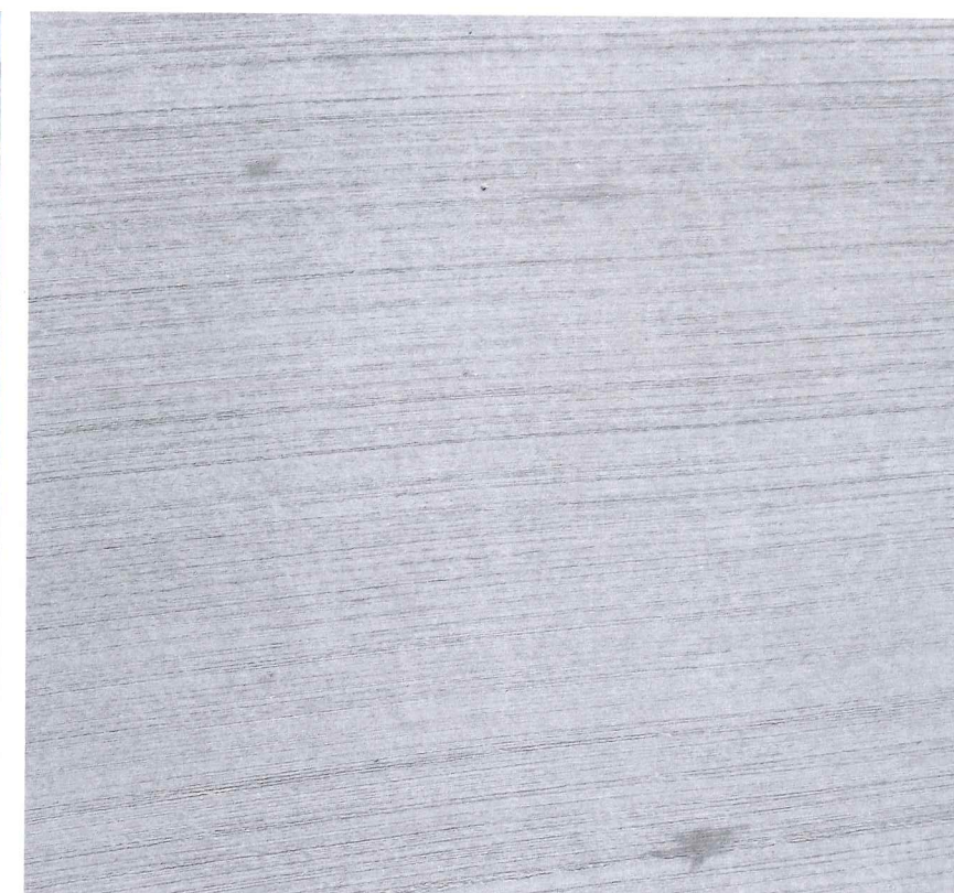
Hlavní osová trasa z česaného betonu
