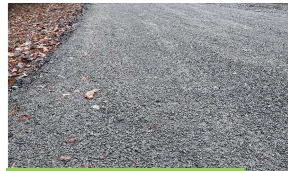
Mechanicky zpevněné kamenivo
