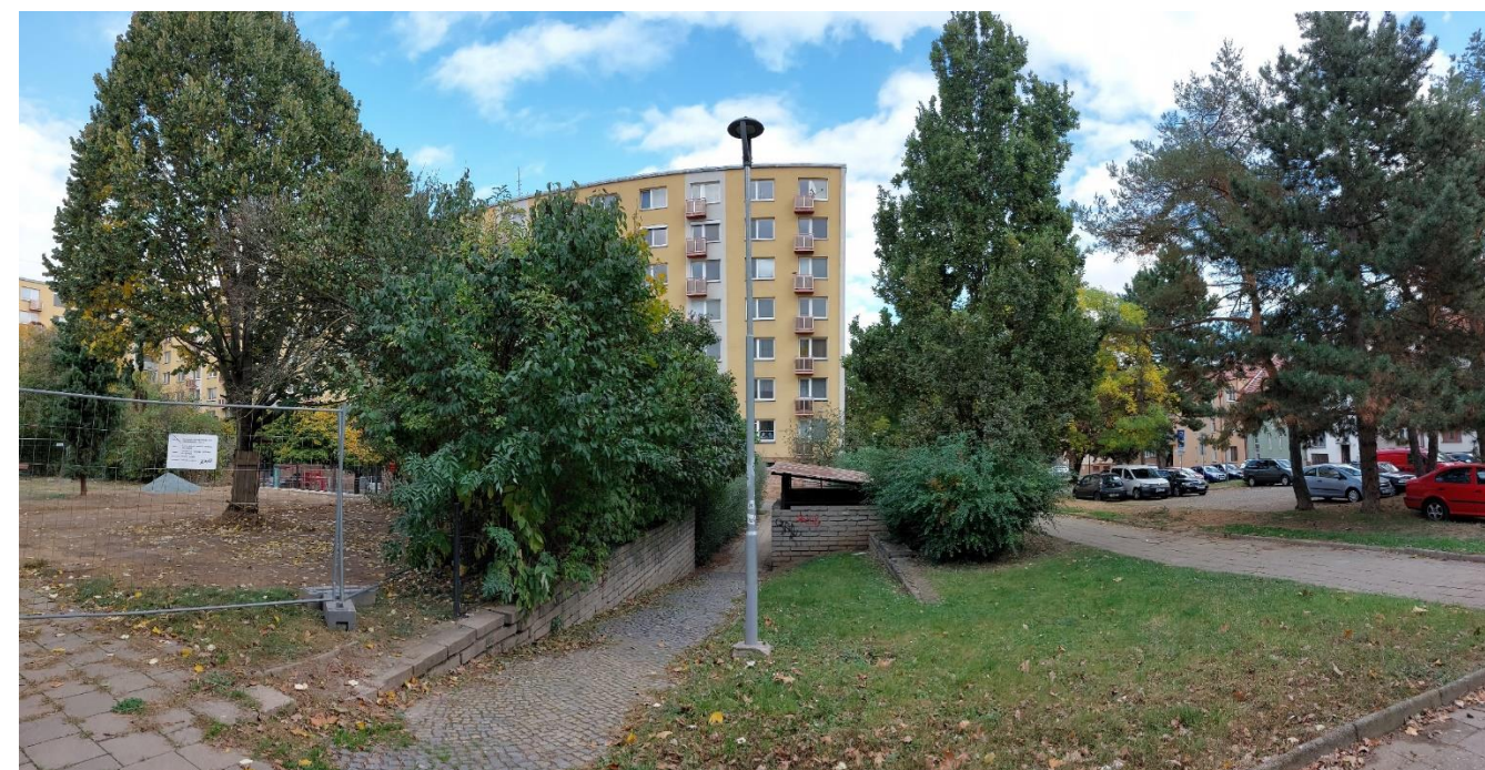
JIŽNÍ ČÁST – POHLED Z PROSTORU OD KOTELNY – Z JIHOZÁPADU, VLEVO HORNÍ PARKOVĚ UPRAVENÁ ČÁST, VPRAVO PÁS ZELENĚ S PŘÍSTŘEŠKEM NA TRÍDĚNÝ ODPAD
