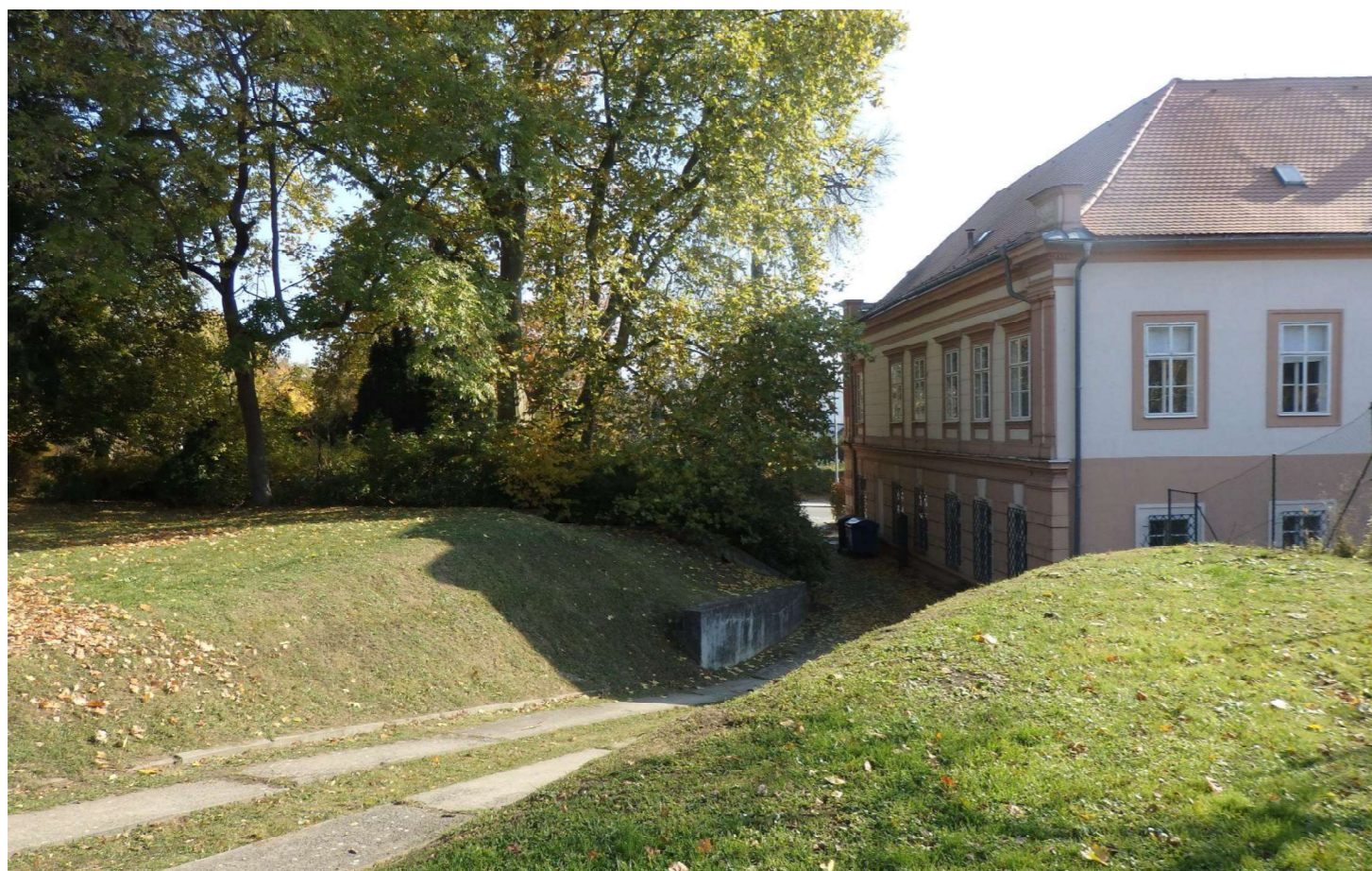
Pohled na hlavní vjezd do území.
