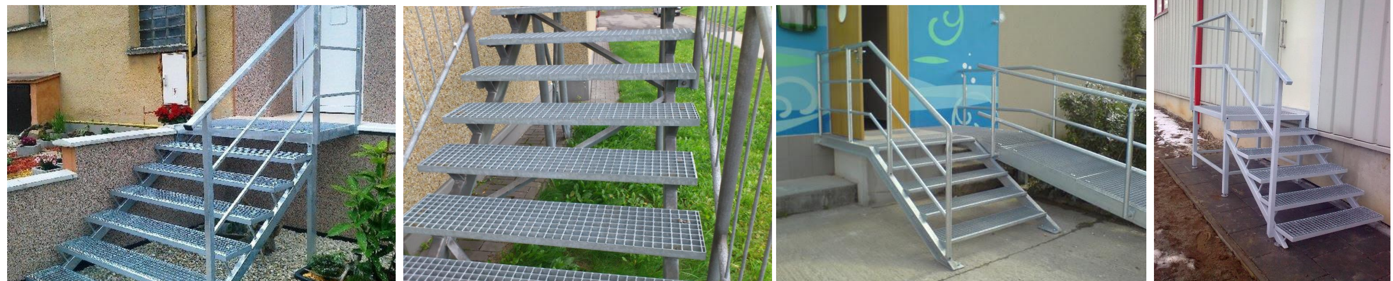
Ocelové schodiště – pozink, pororošt
