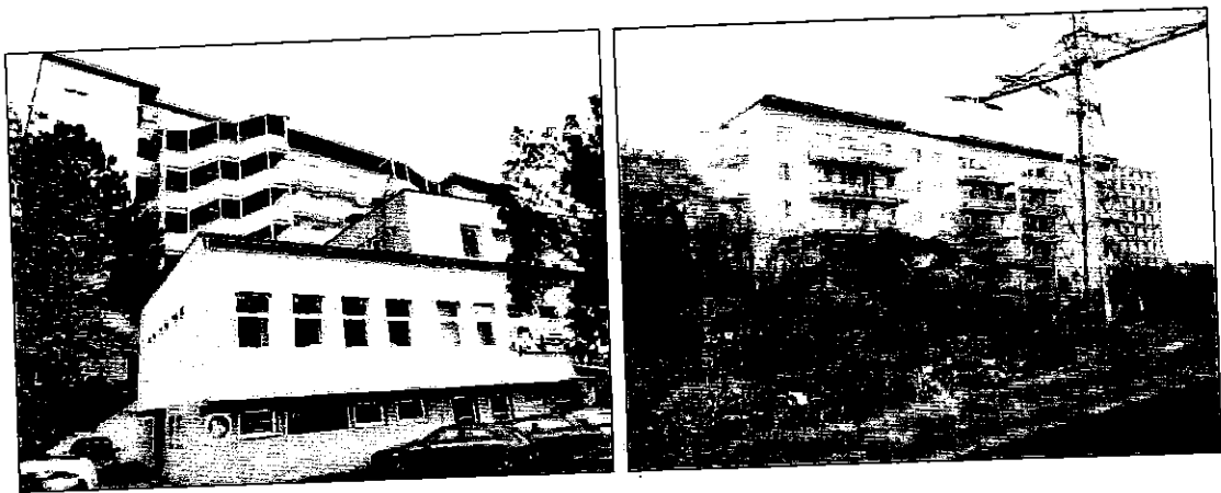
Obr.č. 1,2 Budova č.p. 1191 na p.č. 1658/5 a p.č. 1658/6 – pohledy uliční (západní) a východní
