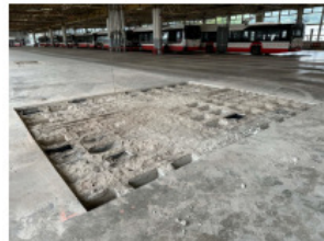
PŘÍKLAD UBOURANÉ HORNÍ ČÁSTI SPŘAŽUJÍCÍ STROPNÍ DESKY
