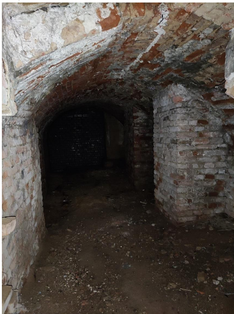
Pohled do podzemních prostor
