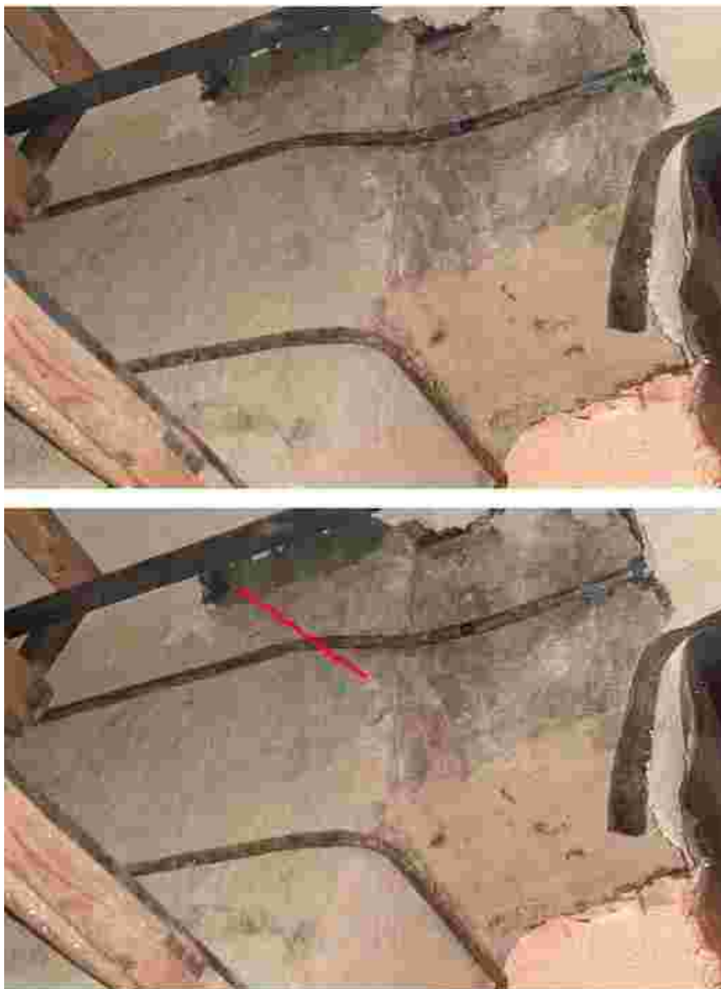
Obr.55-56: Typická trhlina ve sloupu, v místě rámového styčnicku, sonda Sc4J. Na spodním obrázku je pro názornost trhlina zvýrazněna červeně.
