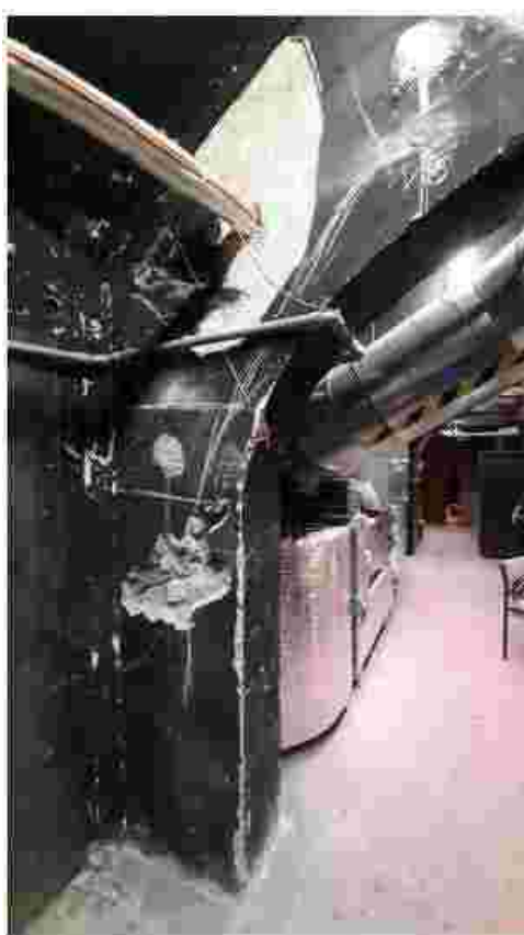
Obr.11 : Celkový pohled na místo sondy S5M spolu s vykreslením polohy trhlin a výztuže jasně ukazuje, že průběh trhliny souvisí se způsobem vyztužení, a velkou roli hraje poloha těmínků ve sloupu.
