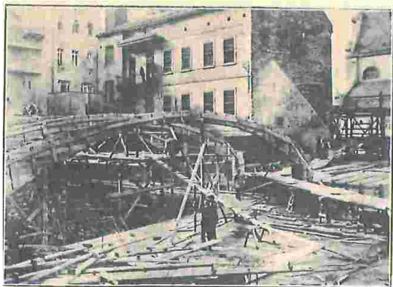
Bednění obloukové střeby nad slavnostním sálem.
