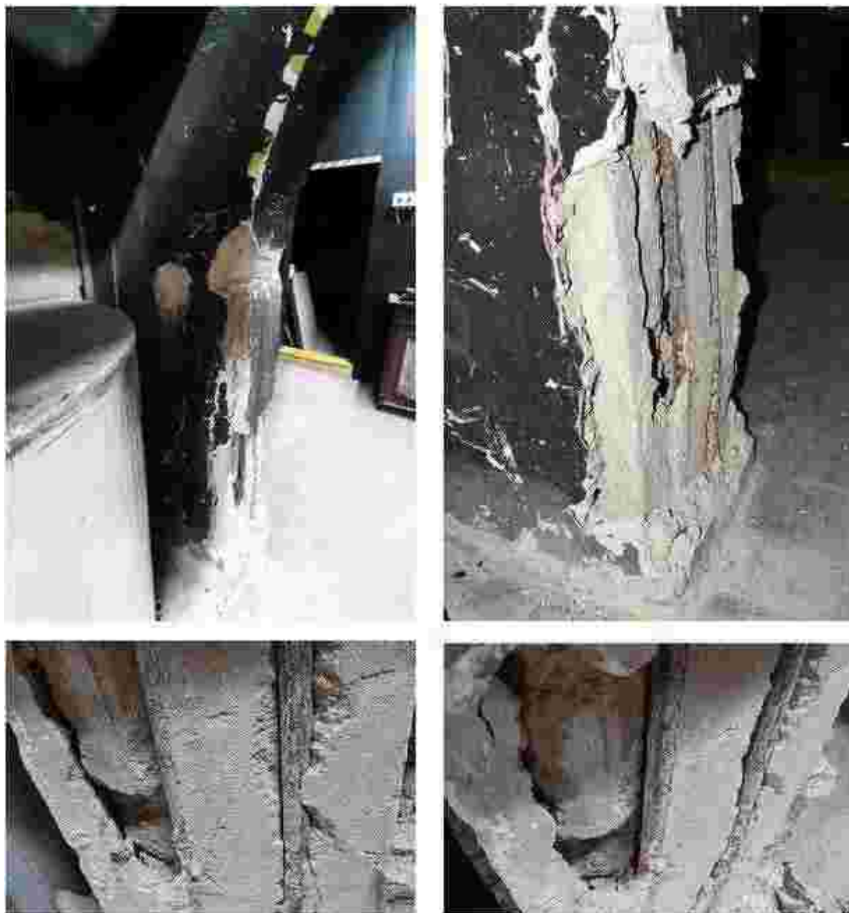
Obr.22-25 : Po odstranění omítky se ukázal celý rozsah poškození sloupu v sondě S5J, kde hlavní výztuž v čele sloupu je i z částí betonu vytržena (vyboulena) směrem do prostoru divadla. Za zmínku stojí i nulové krytí výztuže, které souvisí s absencí třmínků. Je zcela odtržena čelní strana sloupu s výztuží až do výšky 1200 mm nad podlahou, z této strany se odděluje se dvojice vodorovných trhlin napříč sloupem ve výšce cca 750 mm nad podlahou.
