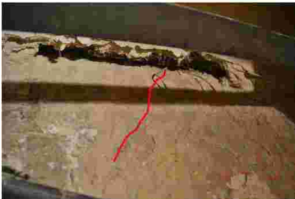
Obr.63-64: Typická trhлина ve sloupu, v místě rámového styčnicku, sonda Sc6M. Na spodním obrázku je pro názornost trhлина zvýrazněna červeně.
