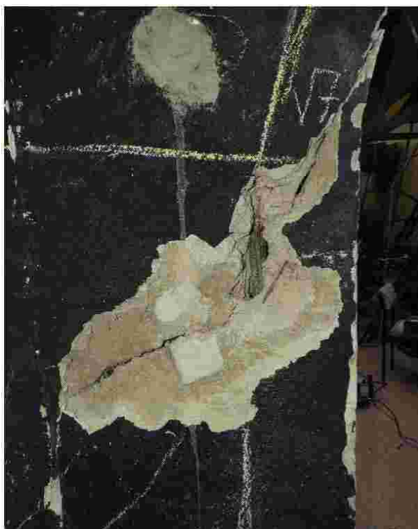
Obr.9 : Po odstranění části uvolněného betonu v trhlíně v sondě S5M byla zjištěna hlavní výztuž z oblouku, vytržená z původní polohy.
