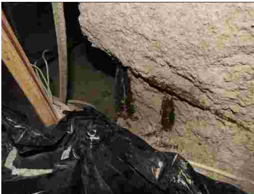
Obr. 11: Sloup Sc6M s výrazným narušením a odtržením krycí vrstvy betonu korodující výztuží v patě sloupu, po odstranění odtržené vrstvy je dobře patrná masivní koroze výztuží
