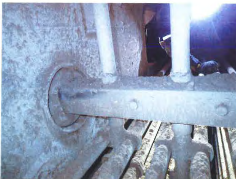
Obr. 1.4-4 – Trubkový svazek ekonomizéru, trámec systému oklepávání P4100158 –
