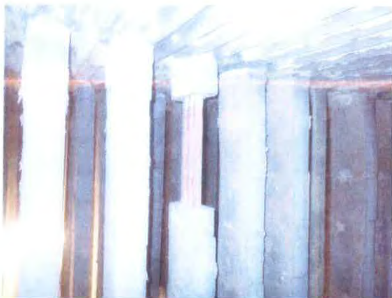
Obr. 1.3-1 – Závěsné trubky přeříváku páry P4100029 –
