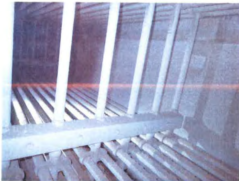
Obr. 1.4-3 – Trubkový svazek ekonomizéru, trámec systému oklepávání P4100157 –
