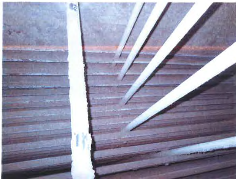
Obr. 2.4-1 – Trubkový svazek ekonomizéru P4160076 –
