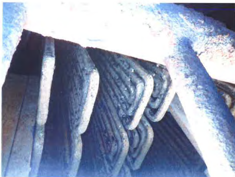
Obr. 2.3-2 – Trubky přehříváku páry P4160041 –
