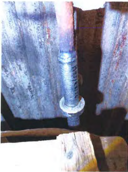
Oprava přechodového kusu mezi inconelem chráněnou trubicou přehříváku a závěsnou trubicou.
