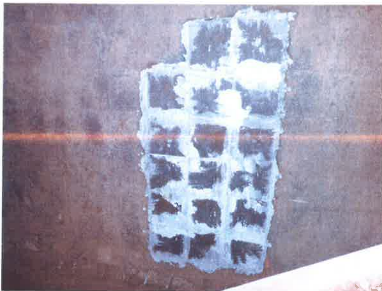
Obr. 2.1-7 – Obnovená zadržka stěny spalovací komory P4160026 –
