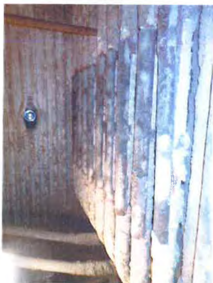
Obr. 1.2-6 – Trubky trubkového svazku P4100203 –
