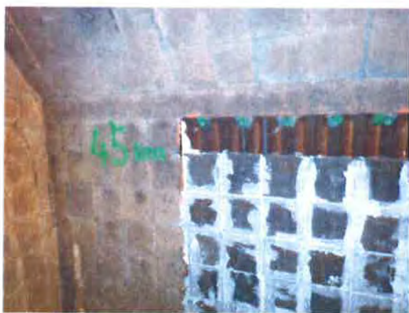
Obr. 2.1-2 – Obnovená zazdívka stěny spalovací komory P4160015 –
