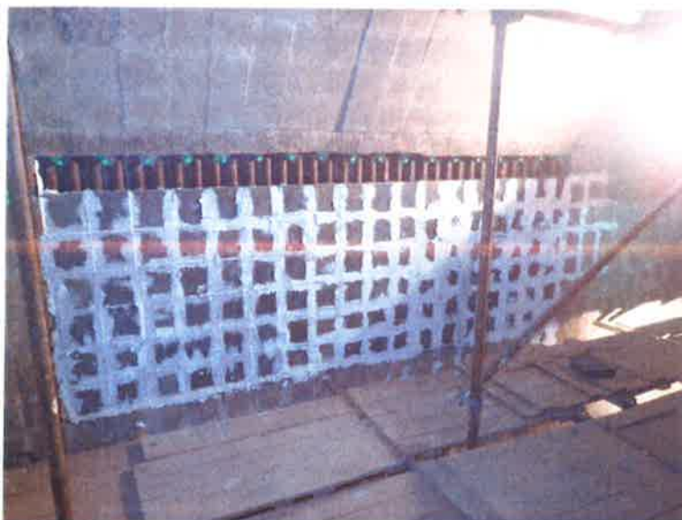
Obr. 2.1-3 – Obnovená zazdívka stěny spalovací komory P4160016 –
