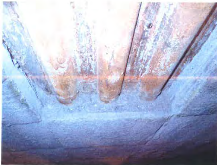
Obr. 2.1-9 – Nový typ dlaždic zezdívky – překrývá tři trubky membránové stěny P4160039 –
