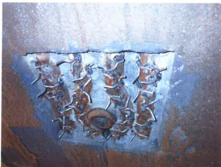
Obr. 2.1-8 – Příprava pro vyzdívku vzduchové dyšny P4160031 –
