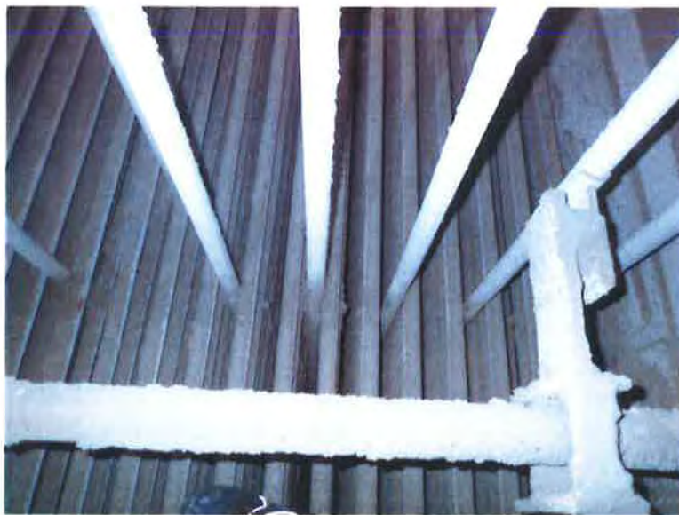
Obr. 2.4-2 - Trubkový svazek ekonomizéru, P4160077 –
