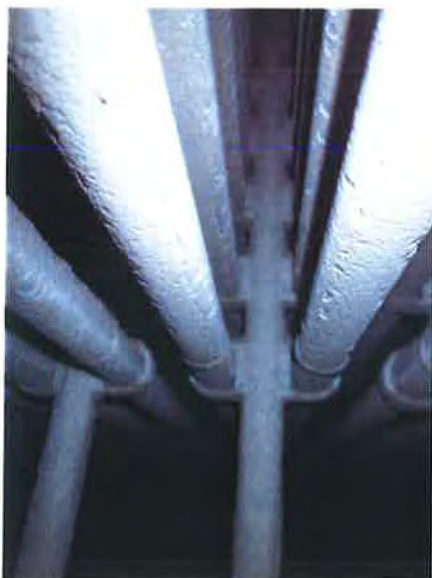
Obr. 1.4-6 – Závěsný systém trubek ekonomizéru P4100167 –
