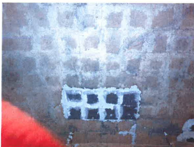
Obr. 2.1-6 – Obnovená zazdívka stěny spalovací komory P4160024 –
