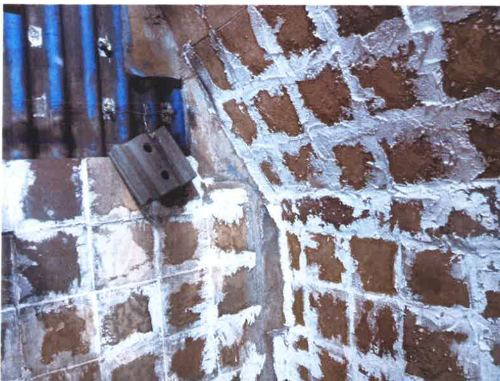
Oprava vyzdívky spalovací komory
