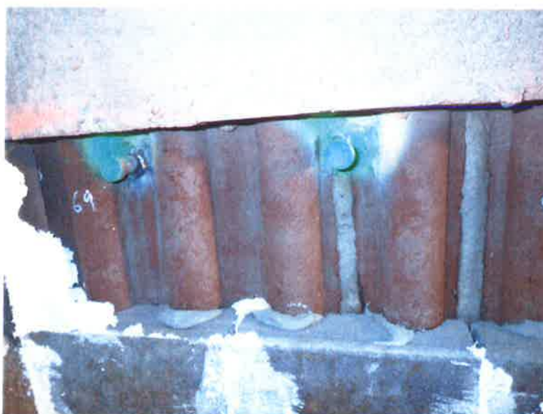
Obr. 2.1-4 – Obnovená zazdívka stěny spalovací komory P4160017 –
