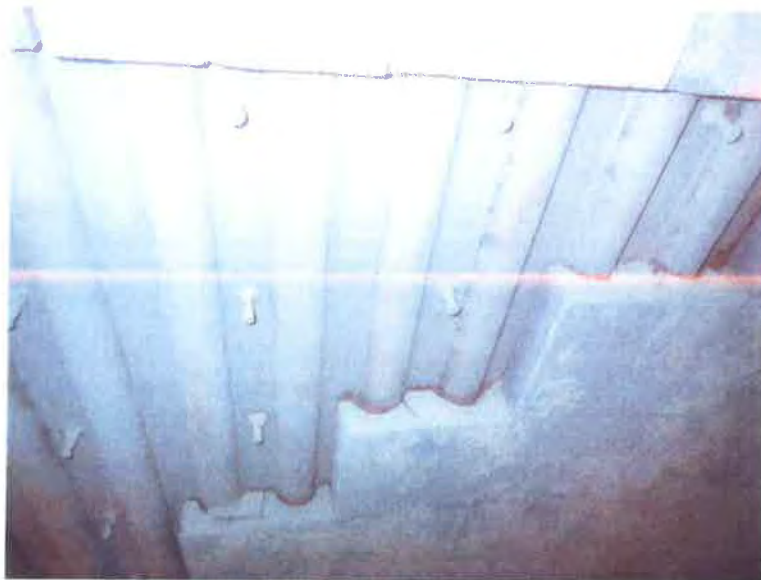
Obr. 1.1-5 - Membránová stěna včetně zazdívkový P4100053 –
