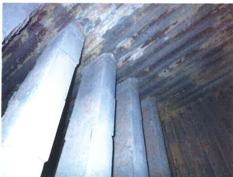
Obr. 1.3-8 – Závěsné trubky přehříváku páry P4100110 –
