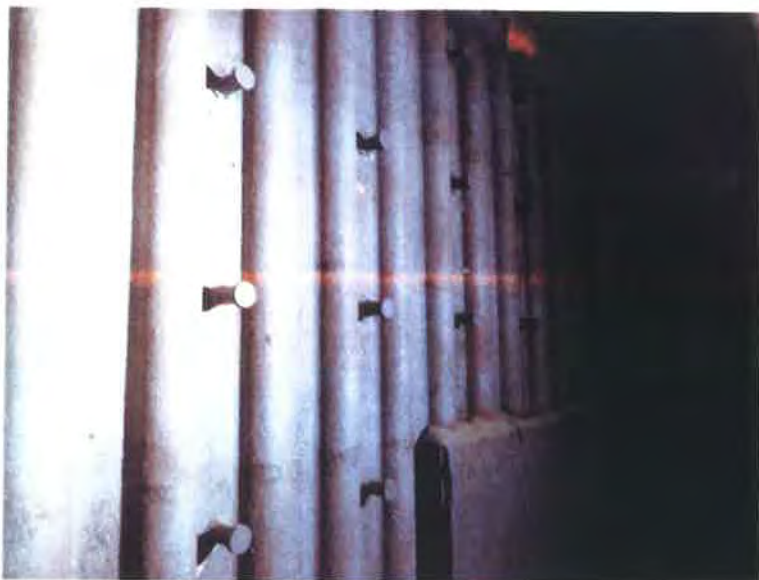
Obr. 1.1-7 – Membránová stěna a závěsné trny pro zazdívku P4100089 –
