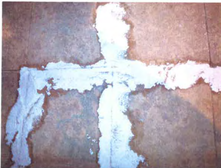
Obr. 2.1-1 – Obnovená zazdívka stěny spalovací komory P4160012 –
