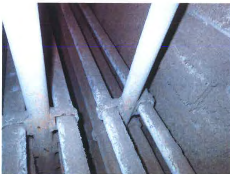
Obr. 2.4-6 – Závěsný systém trubkových svazků ekonomizéru P4160085 –
