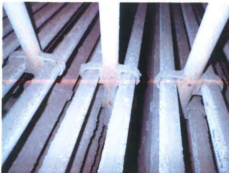
Obr. 2.4-5 - Závěsný systém trubkových svazků ekonomizéru P4160084 –
