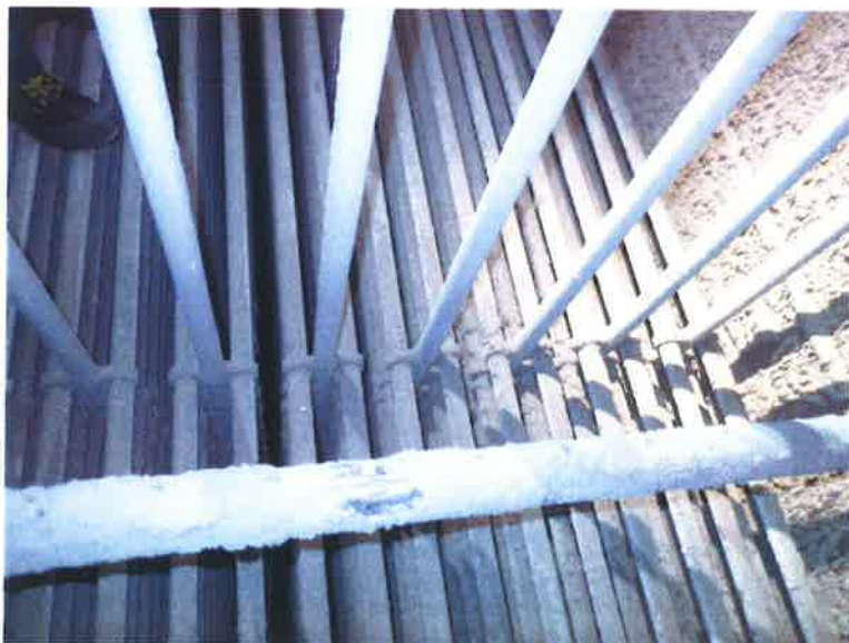
Obr. 1.4-2 – Trubkový svazek ekonomizéru P4100156 –
