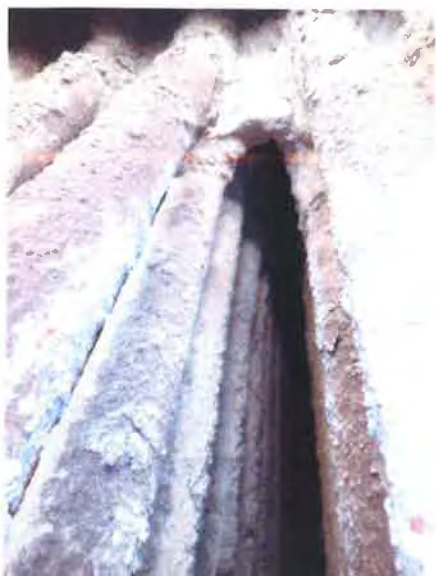
Obr. 2.2-1 – Trubky trubkového svazku P4160044 –
