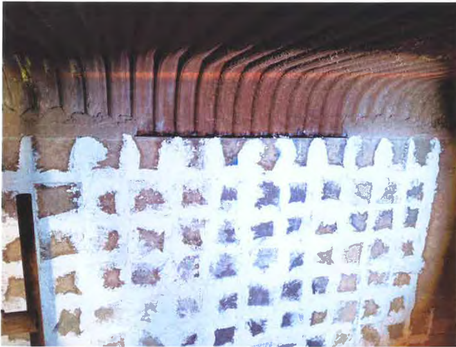
Oprava vyzdivky přední stěny spalovací komory
