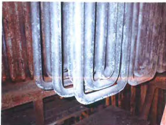
Obr. 2.3-5 – Trubky přehříváku páry kryté návarem P4160053 –
