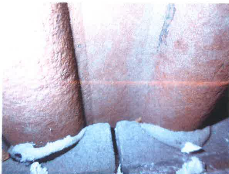
Obr. 2.1-5 – Obnovená zazdívka stěny spalovací komory P4160018 –
