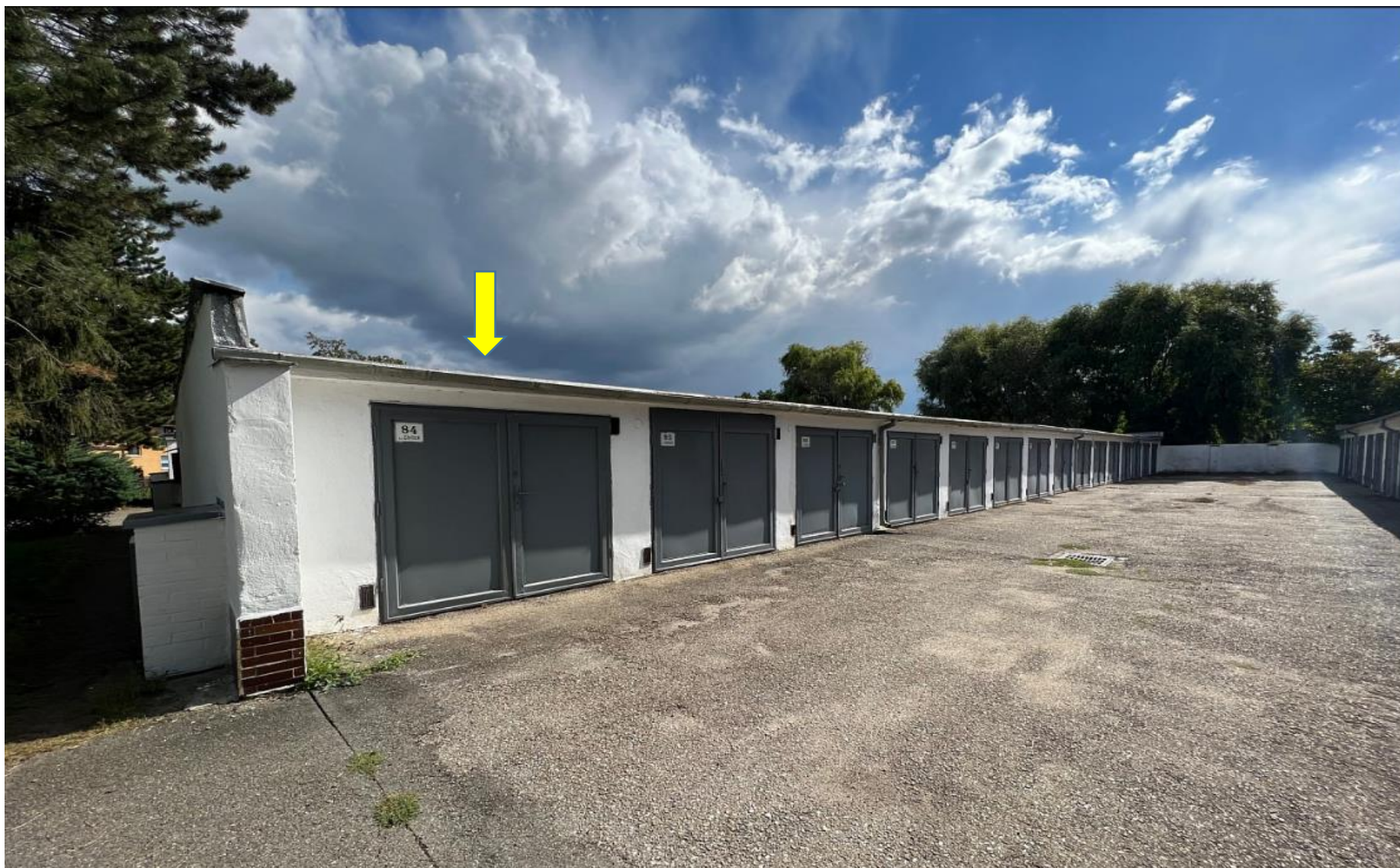
Fotografie garáže na p.č. 221/33 k.ú. Chrlice
