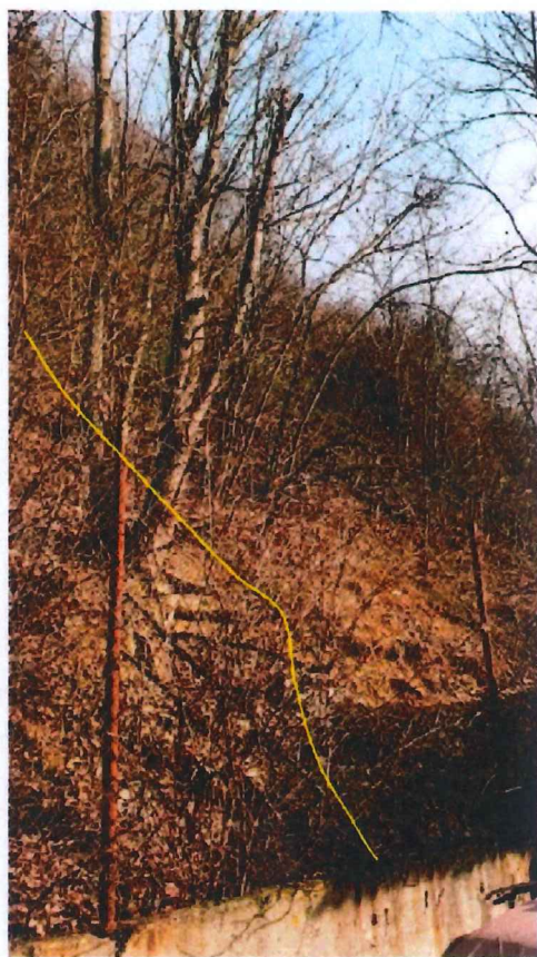
Obrázek 13: Pohled na povahu svahu v krajním prostoru, vlevo od hlavního narušení zdi, znatelné ještě stopy po předchozím odkopu svahu pro výstavbu zárubní zdi, vyznačena linie změny strmosti svahu s obnaženým kořenovým systémem vzrostlých stromů.
