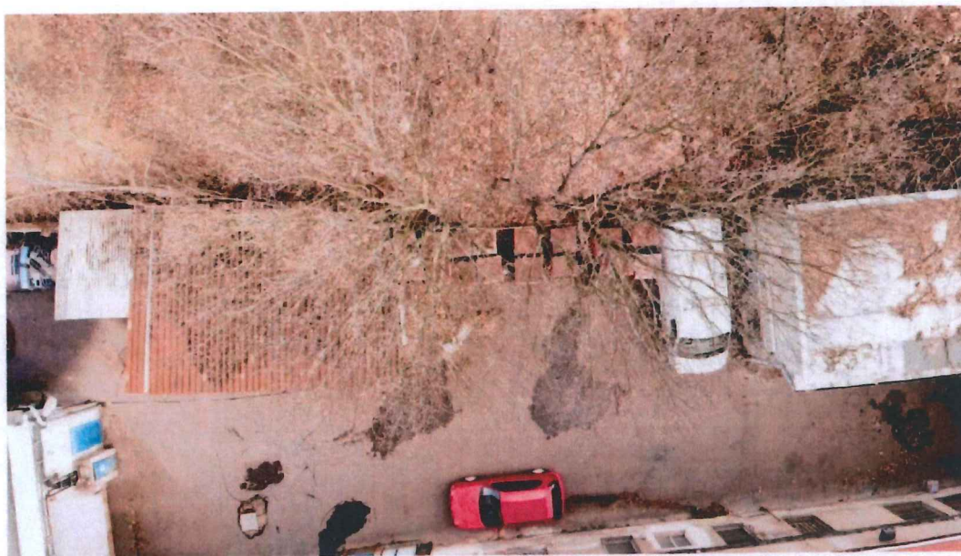
Obrázek 6: Horní pohled na hodnocené místo, zcela zřejmý blízký vzrůst stromů u zdi a splach sprašových hlín na oplocení a zárubní zeď nad míru vhodnou
